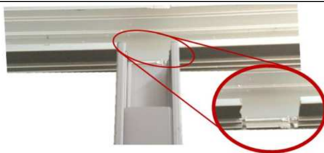
Intersección en perfil sin ceja lateral
